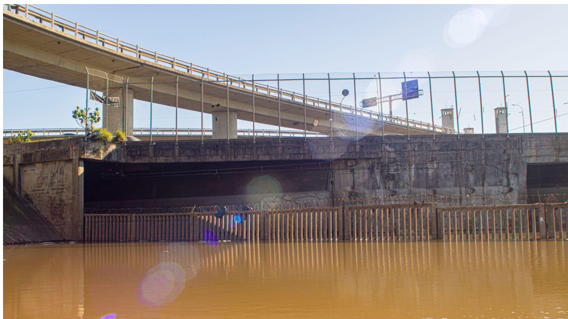
FIGURA 5: ESTAÇÃO DE TREM ALAGADA
