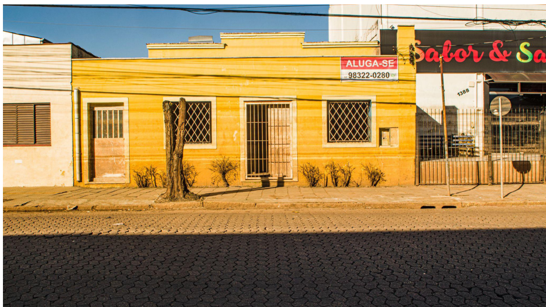
FIGURA 9: MARCAS DAS ÁGUAS NAS PAREDES
